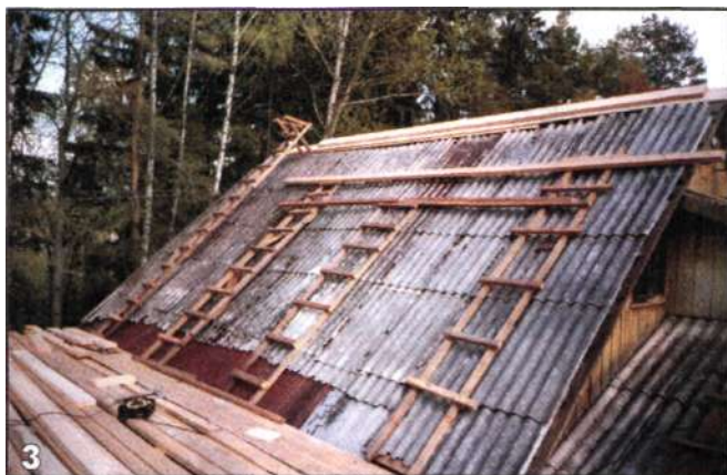
Монтаж конькового прогона.
